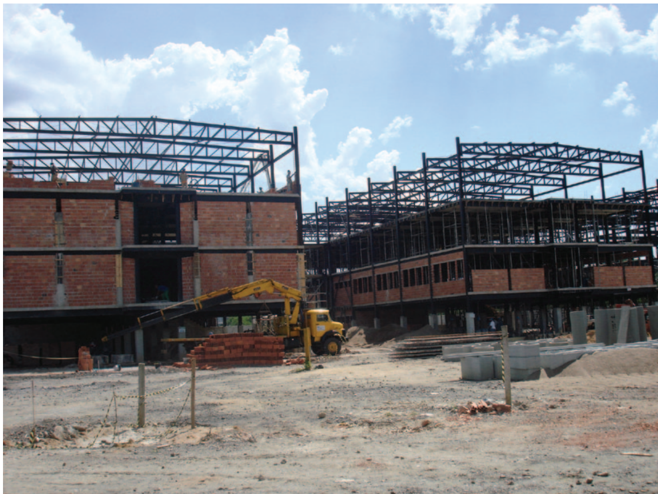
Situação da obra: em andamento do Campus do Aterrado / PUVR
