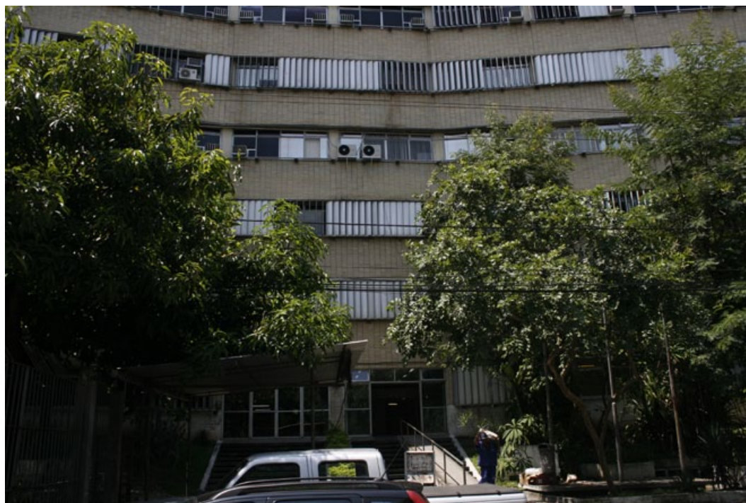
Fachada do prédio atual.
