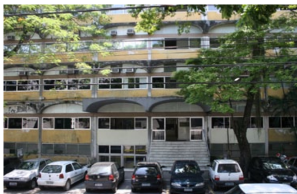
Fotos da fachada do prédio existente.
