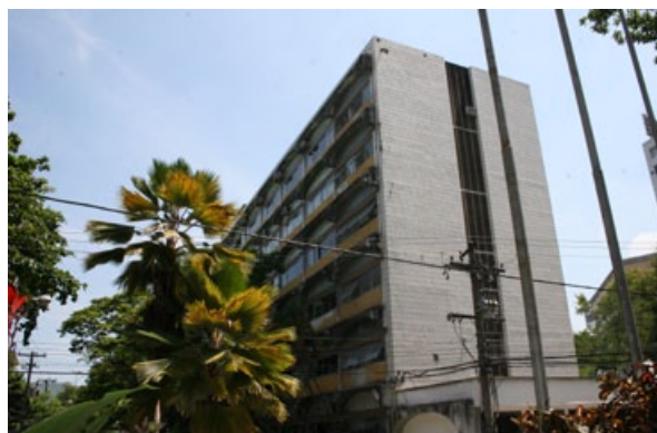
Fotos da fachada do prédio existente.
