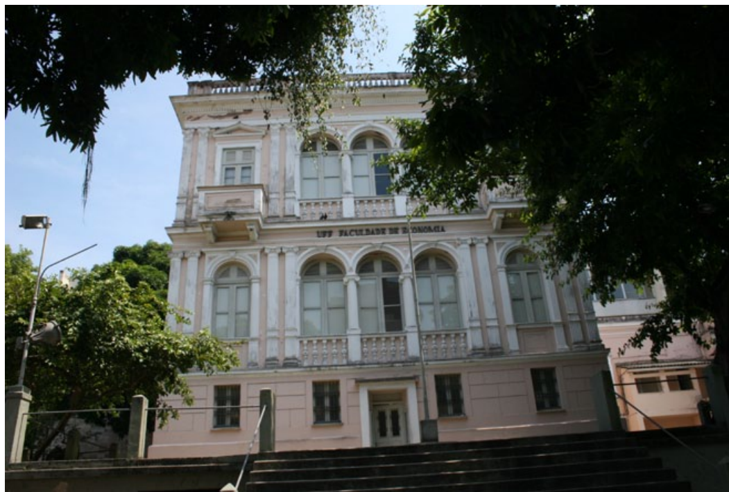
Fachada do prédio atual.
