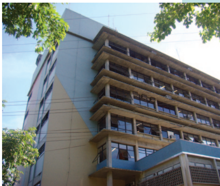
Vista da torre que será reformada
