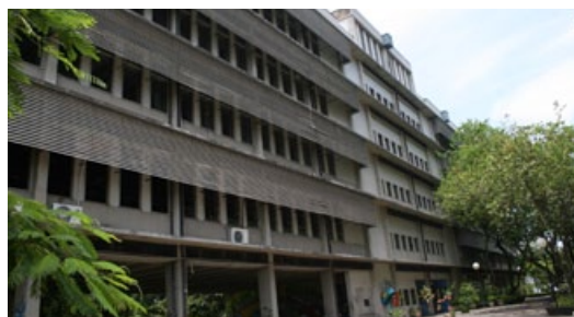
Fachada do prédio atual.
