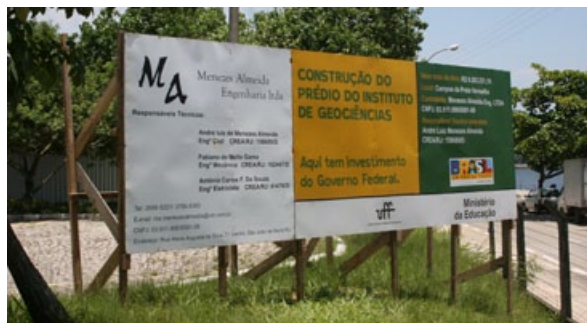
Canteiro da obra em andamento.
