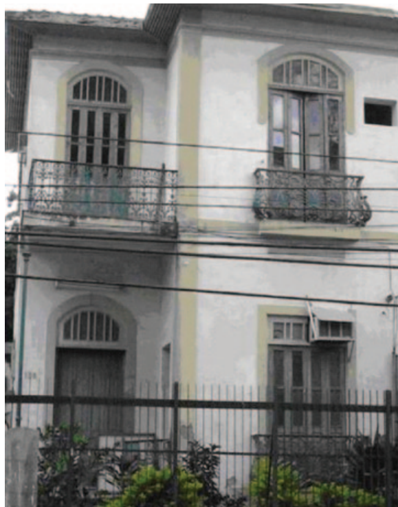
Fachada antes da restauração
