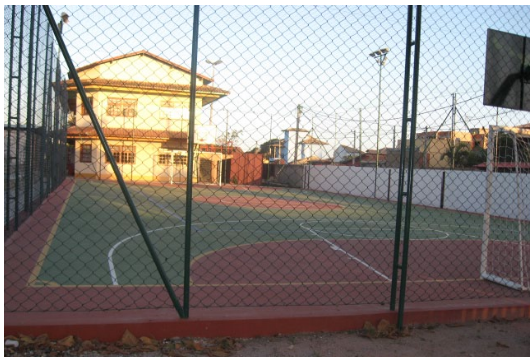
Situação: obra concluída
