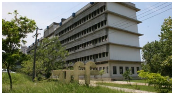
Fachada do prédio atual.
