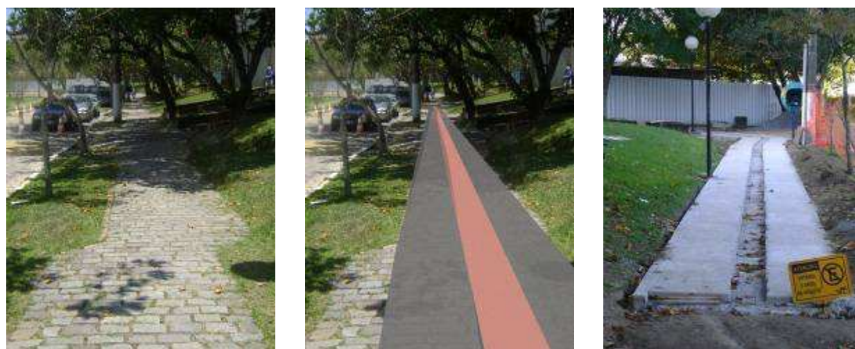
Figura nº 09: Da esquerda para a direita: calçada de acesso aos blocos; simulação do caminho; obra em execução. Fonte: SUEP. Projeto de Acessibilidade para o campus do Gragoatá. Niterói, 2011.
