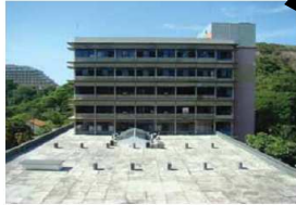
Local onde será construída a nova torre
