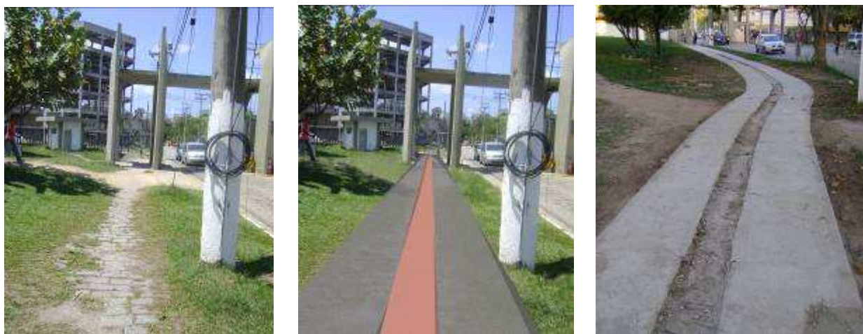
Figura nº 08: Da esquerda para a direita: vista da guarita; simulação do caminho; obra em execução. Fonte: SUEP. Projeto de Acessibilidade para o campus do Gragoatá. Niterói, 2011.
