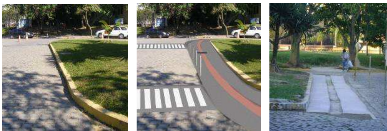
Figura nº 10: Da esquerda para a direita: canteiro a ser recuado; simulação do caminho; obra em execução. Projeto de Acessibilidade para o campus do Gragoatá. Niterói, 2011.
