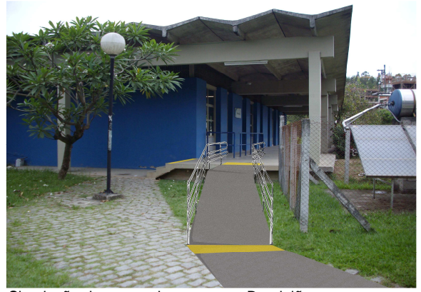
Simulação da rampa de acesso ao Banheiro.
