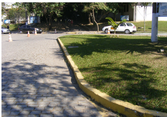
Canteiro a ser recuado.
