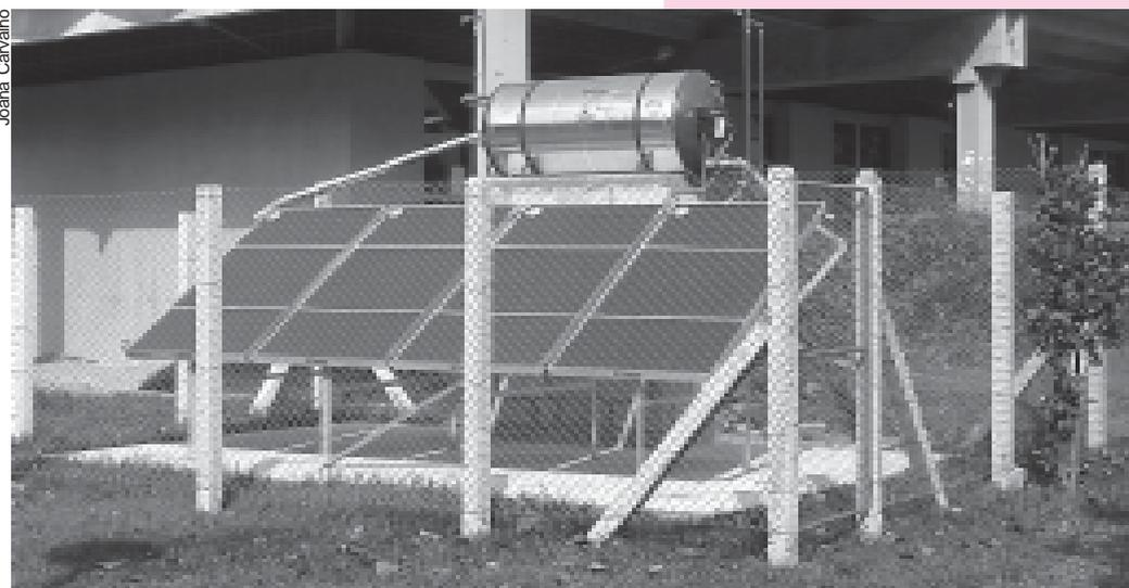
Placas coletoras de energia solar e reservatório térmico
