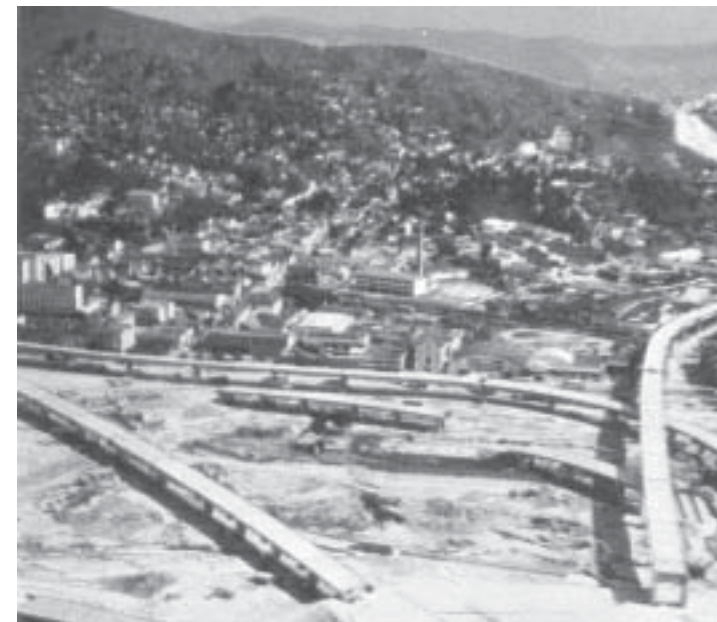
Construção dos viadutos de acesso à Ponte Rio-Niterói e ao Centro de Niterói
